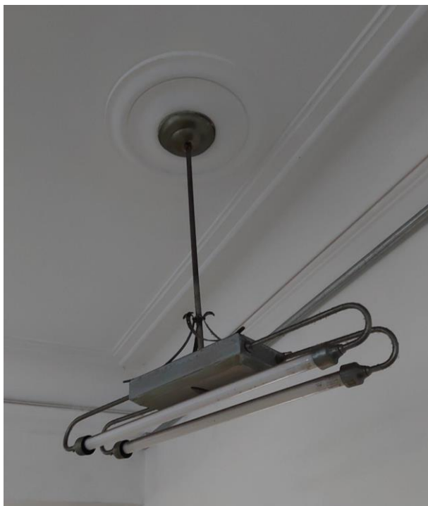
Sede DER-MG. Edifício “A”, variação de luminária pendente com duas lâmpadas tubulares dispostas horizontalmente. Fonte: DIPC, 2023.
