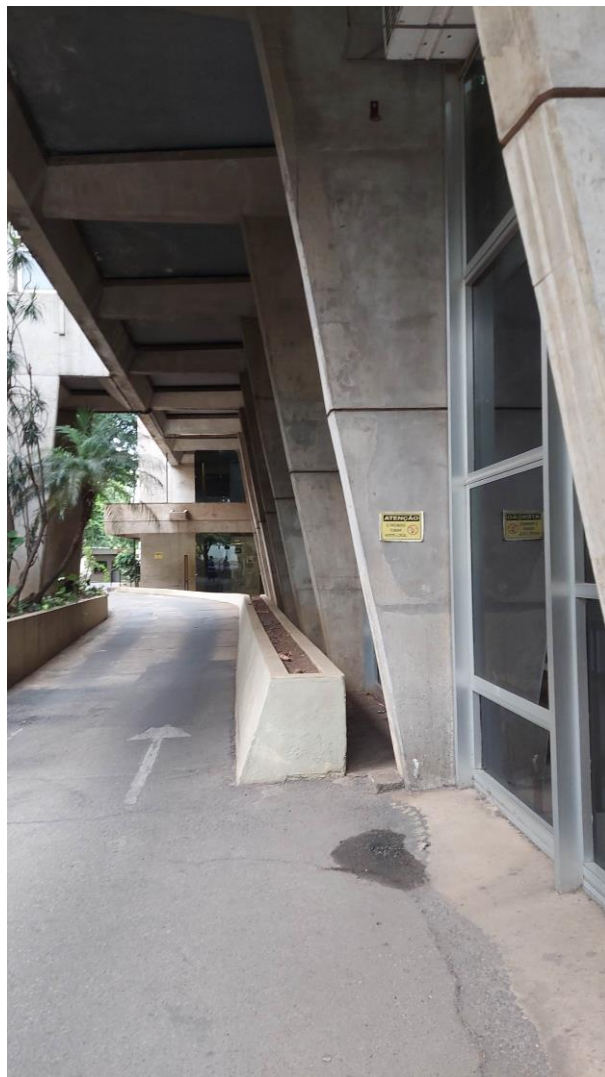
Sede DER-MG. Edifício “B”, detalhe no nível térreo da fachada posterior, em que se destacam as formas geométricas triangulares da estrutura em concreto armado aparente. Fonte: DIPIC, 2023.
