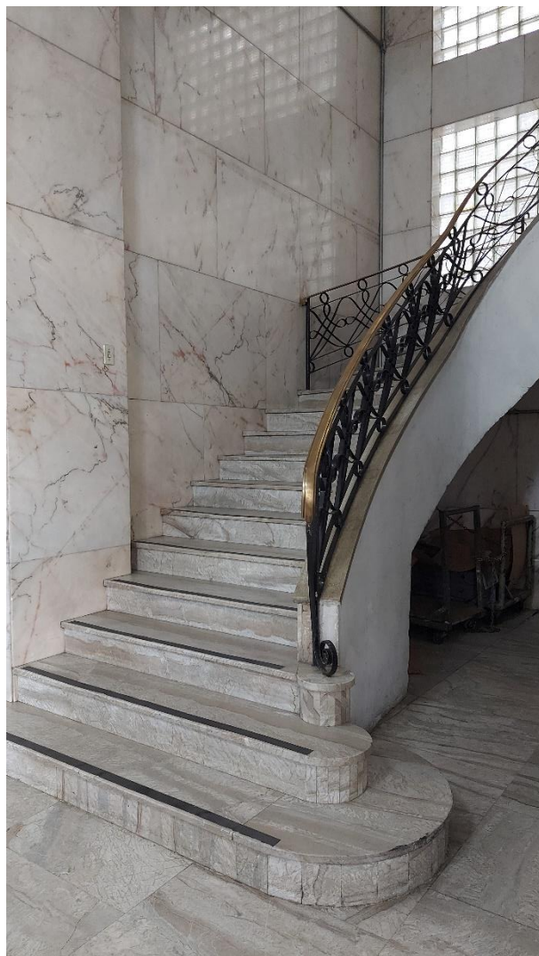
Sede DER-MG. Edifício “A”, destaque para a escada convite revestida em mármore, com corrimão e guarda-corpo metálicos. Fonte: DIPC, 2023.
