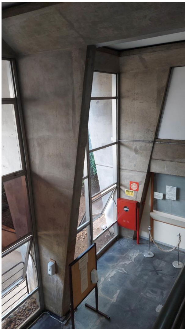
Sede DER-MG. Edifício “B”, detalhe do hall de acesso visto do mezanino, com detalhe para a estrutura em concreto aparente com formas triangulares. Fonte: DIPC, 2023.
