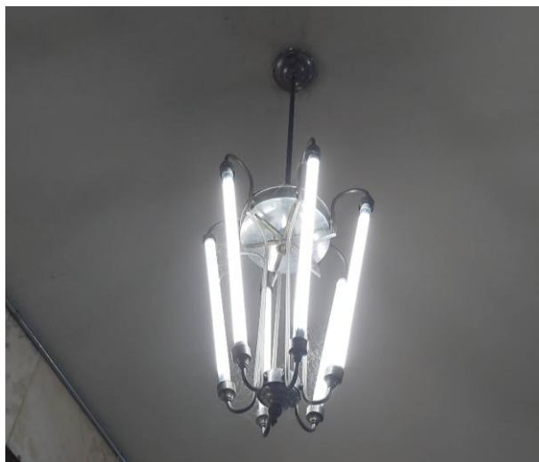
Sede DER-MG. Edifício “A”, variação de luminária pendente com seis lâmpadas tubulares dispostas de inclinadamente compondo uma forma cônica invertida. Fonte: DIPC, 2023.
