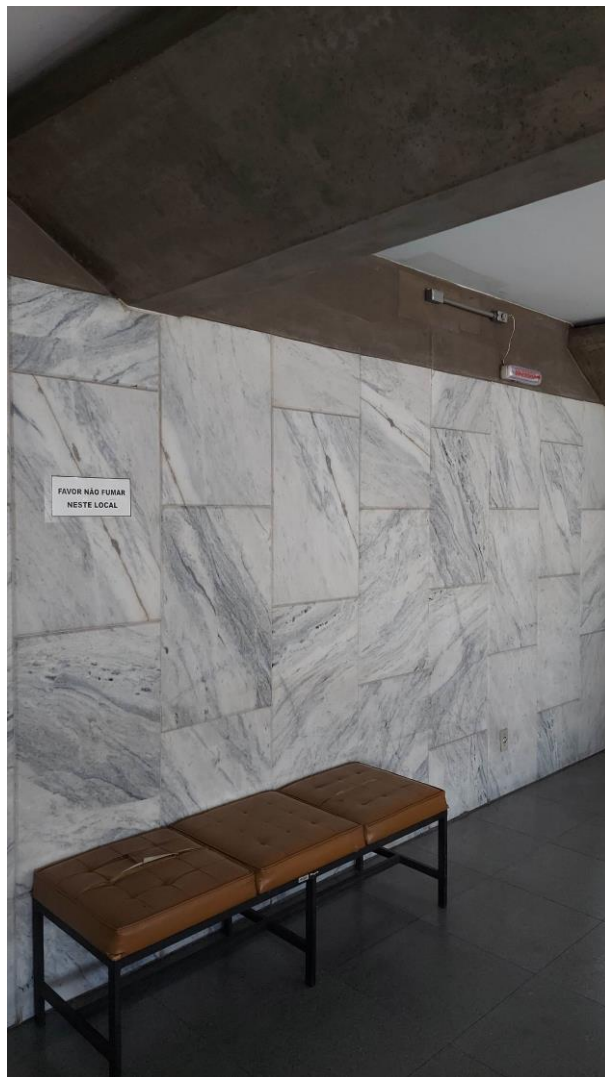
Sede DER-MG. Edifício “B”, detalhe de alvenaria no mezanino revestida em mármore, vigas em concreto aparente e formas triangulares. Fonte: DIPC, 2023.
