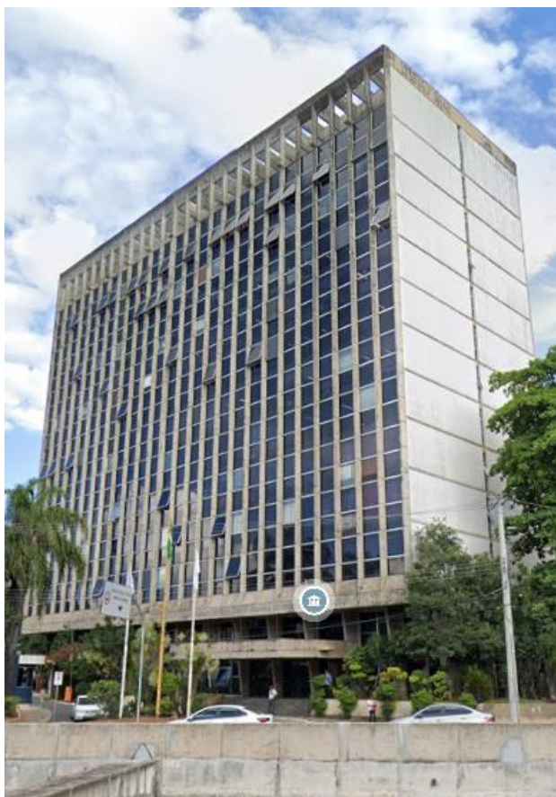
Sede DER-MG. Edifício “B”, detalhe da fachada frontal e lateral direita. Fonte: Google Street View, 2022.
