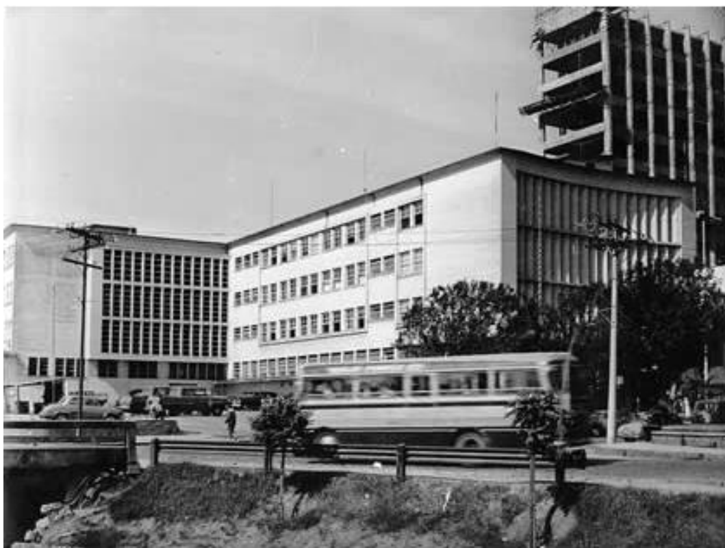
Vista geral da sede do DER/MG a alameda Ezequiel Dias. Fonte: DER/MG, sem data. 35
