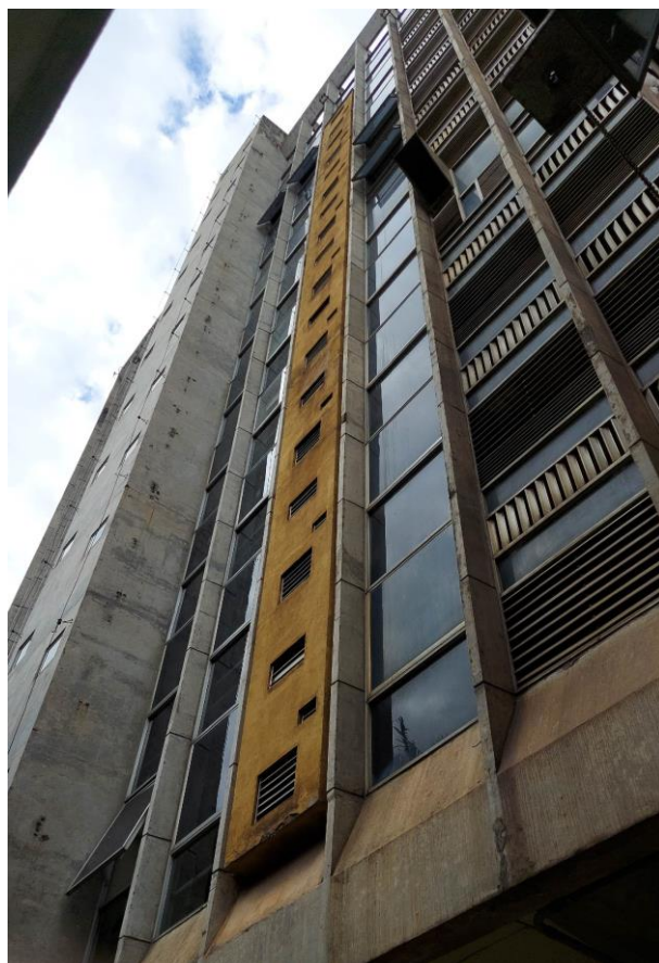
Sede DER-MG. Edifício “B”, detalhe da fachada posterior. Fonte: DIPC, 2023.
