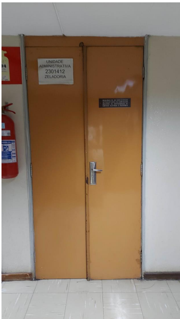
Sede DER-MG. Edifício “B”, exemplar de portas nos pavimentos superiores, revestida em fórmica, piso em Paviflex, rebaixamento em gesso. Fonte: DIPC, 2023.
