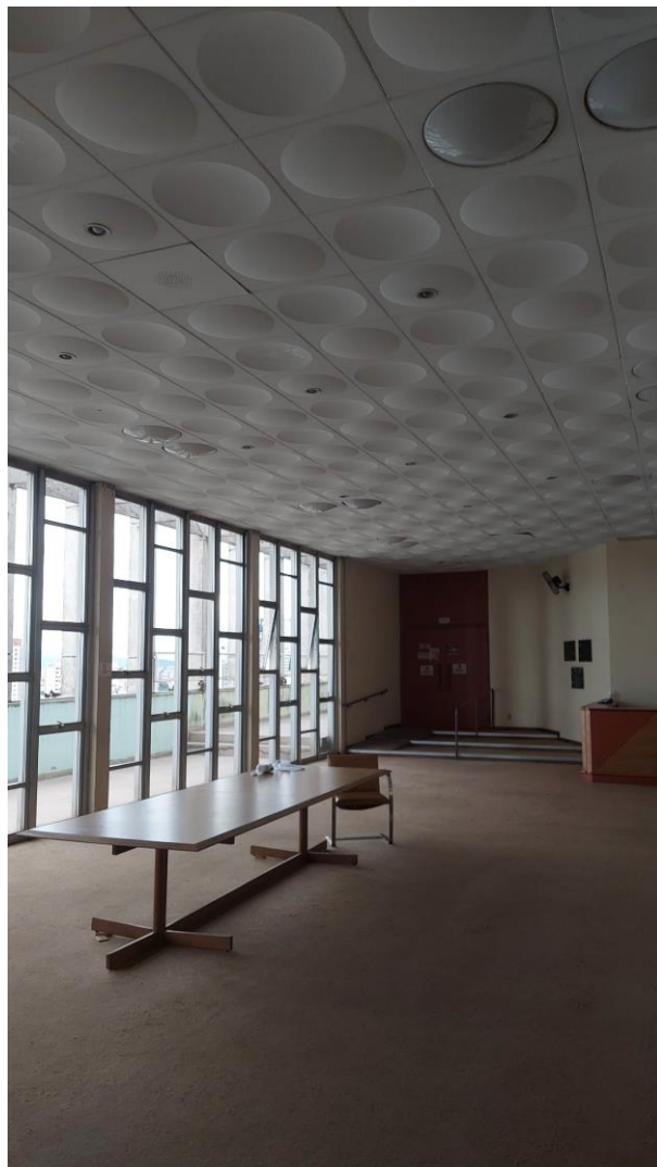
Sede DER-MG. Edifício “B”, foyer do auditório, com acesso ao terraço, piso em carpete e rebaixamento de gesso. Fonte: DIPC, 2023.
