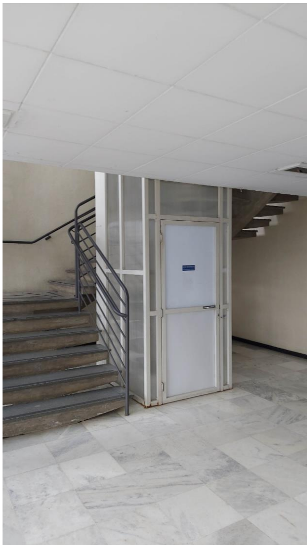
Sede DER-MG. Edifício “B”, escada em concreto e plataforma elevatória que fazem acesso ao foyer do auditório no último pavimento. Fonte: DIPC, 2023.
