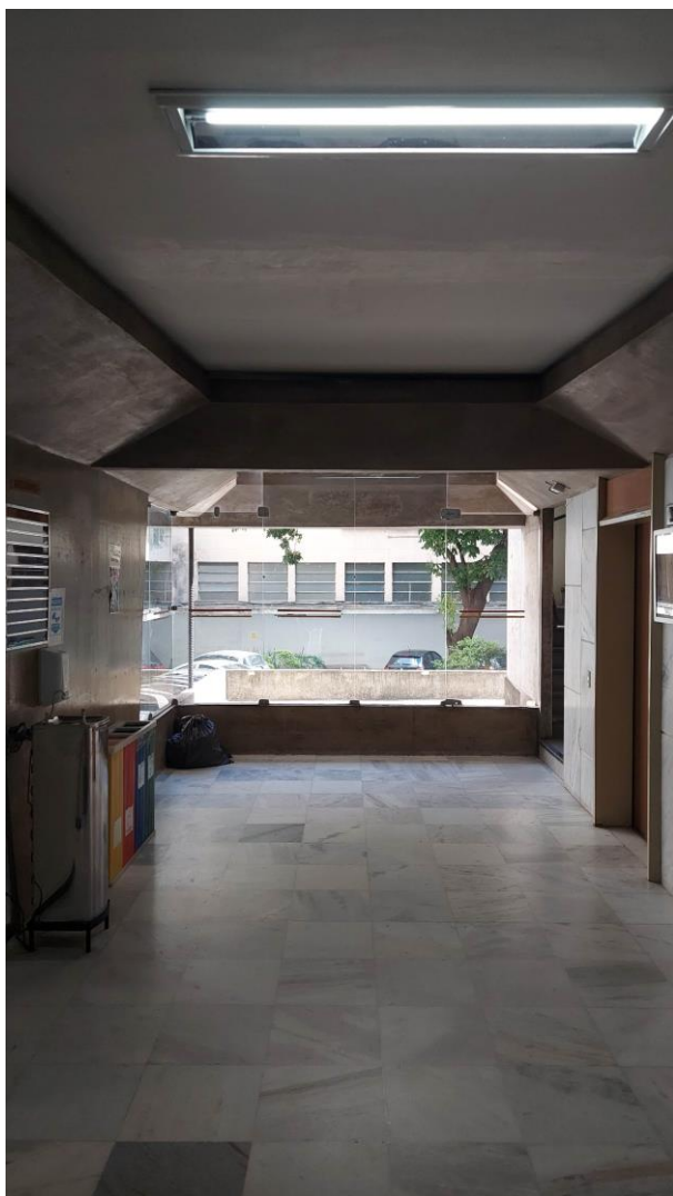
Sede DER-MG. Edifício “B”, detalhe do hall de elevadores no mezanino com revestimento do piso em mármore, estrutura em concreto armado aparente com formas geométricas triangulares. Fonte: DIPC, 2023.
