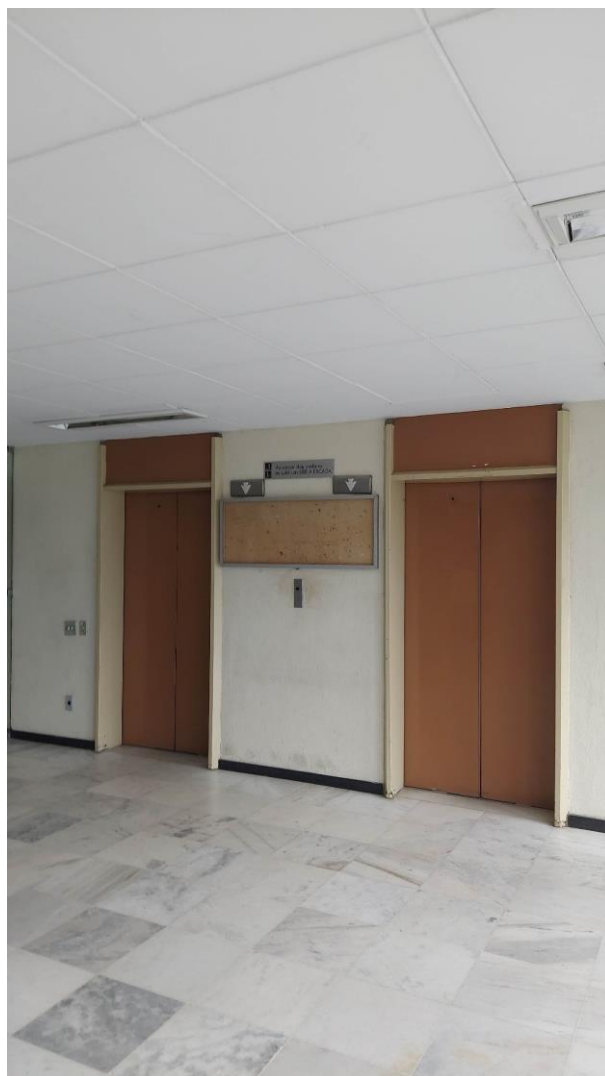
Sede DER-MG. Edifício “B”, exemplar de hall de elevadores, com piso revestido em mármore, rebaixamento em gesso. Fonte: DIPC, 2023.
